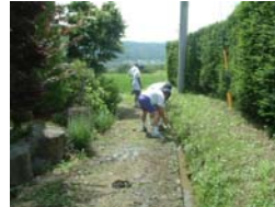
用水路の泥上げ
