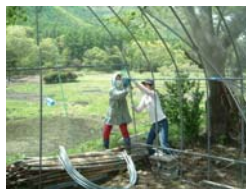
ビニールハウスを立てる
